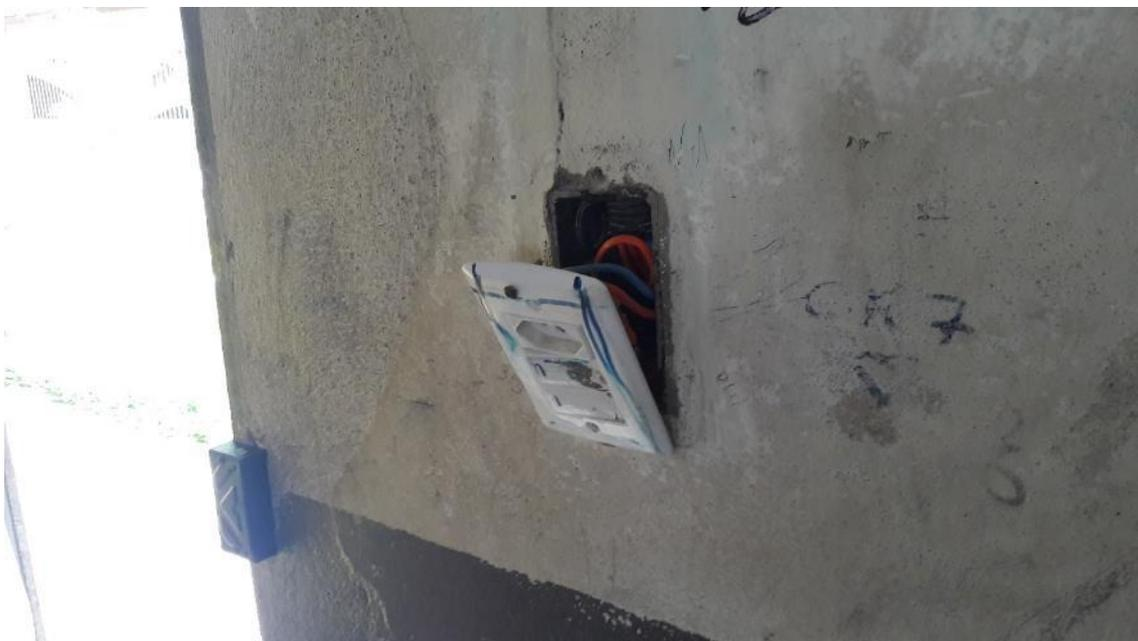
**Imagem 08** - Tomada com a tampa avariada e a fiação exposta
